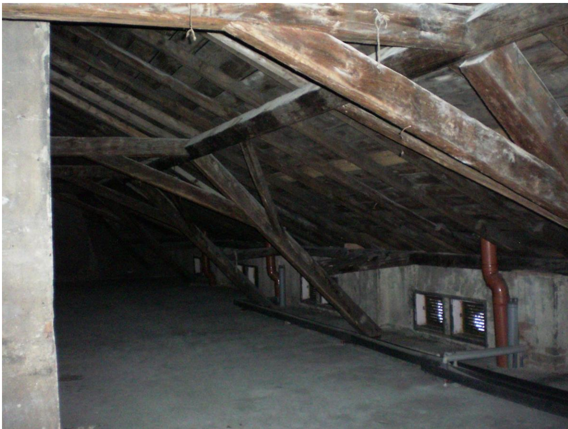
Konstrukce krovu-sedlová střecha
