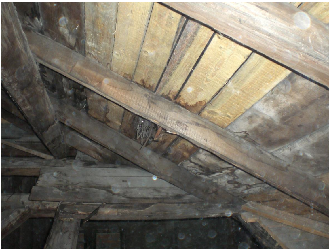
Kritické místo záklopu za kotelnou
