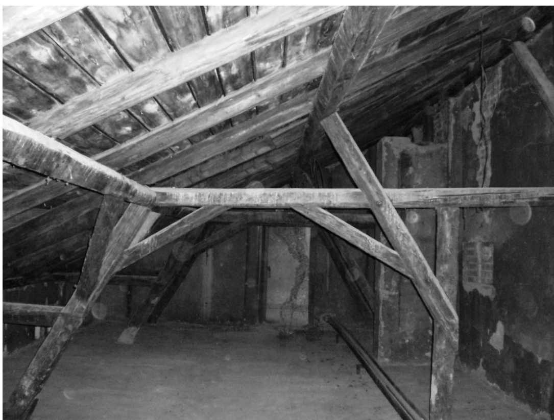
Konstrukce krovy pultové střechy severního křídla
